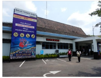
Balai Teknik Sabo Indonesia : インドネシア公共事業省砂防技術センター (在Yogyakarta市)
