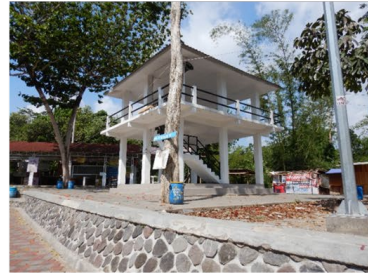
Krasak川下流域泥流氾濫区域内での垂直避難施設
