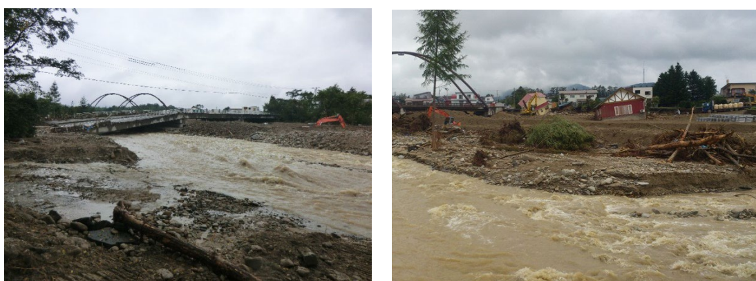
図 2.1 2016 年北海道東部豪雨災害による被害状況（左：落橋（清水町）、右：洪水氾濫（清水町））
