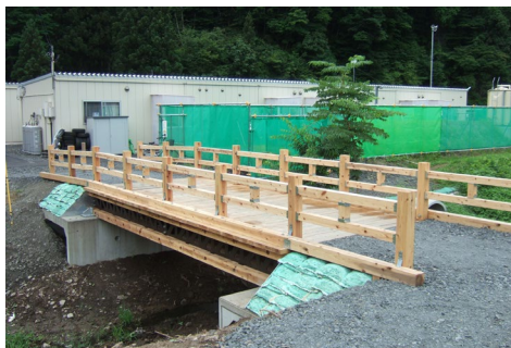
写真－3 角材を用いた仮設橋梁の組立
