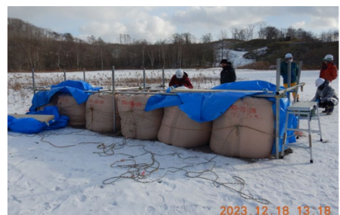
図-3 ソイルセメント中詰めトンパック試験施工 (2023年12月 樽前山麓生川流域)
