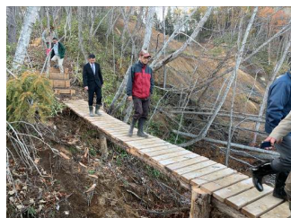
写真-6 カラマツ製材を用いた階段工や床板
