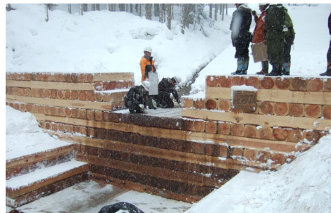
写真－2 木製治山ダムの施工（秋田県鹿角市）
