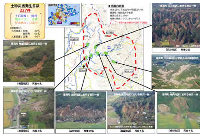
図-1 平成 30 年北海道胆振東部地震による土砂災害 3)
